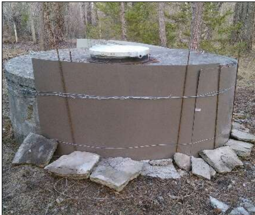
Figure 5 : clichés photographiques du forage des Iscles – renforcement de la protection du puits après la visite du 12/01/2018
