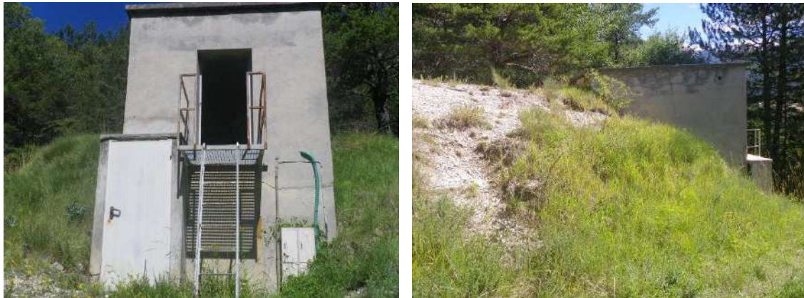
Figure 4 : Réservoir de Saint-Jean-du-Désert, juin 2017
